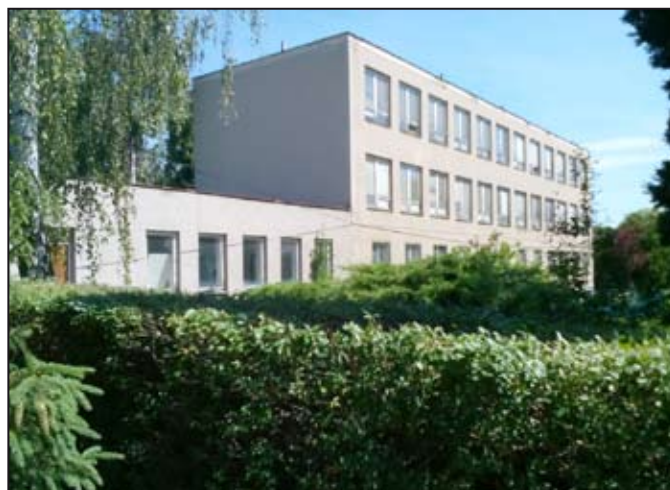
Budova bývalé školky by mohla poskytnout prostory seniorům.
