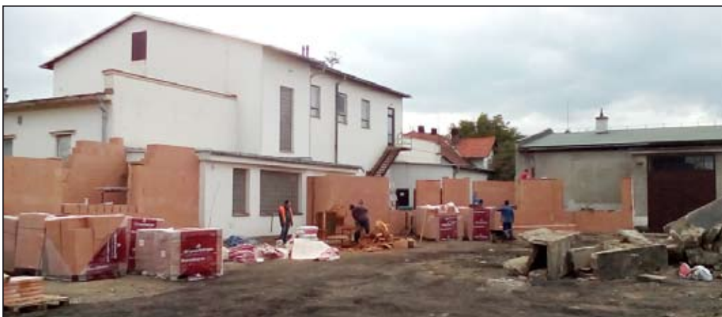
Budování spojovací chodby.
