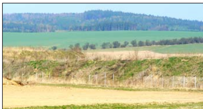
Skládka v Líšnici, foto PŘO
