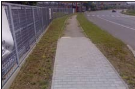
Opravený chodník před rekonstrukcí.
