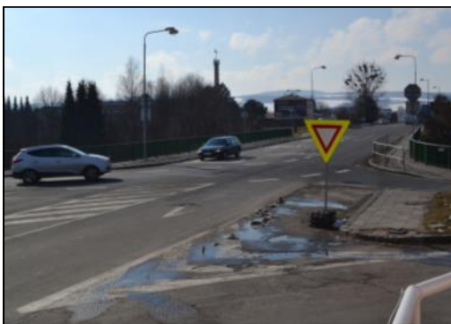
Most na Třebovské ulici.
