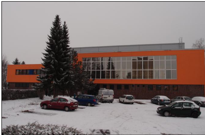
Zrekonstruovaný bazén láká návštěvníky.
