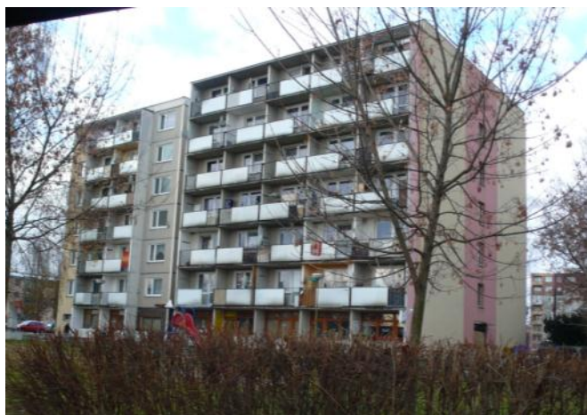
Výměna plastových oken na Nádražní 34.
