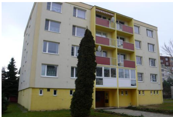
Rekonstrukce lodžii a modernizace výtahu (1. etapa) Na Zámečku č. 11.
