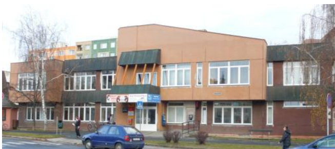
Výměna plastových oken na ulici Nádražní 9.
