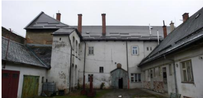
Výměna střešní krytiny, montáž bleskosvodu na ul. Třebovská 30.
