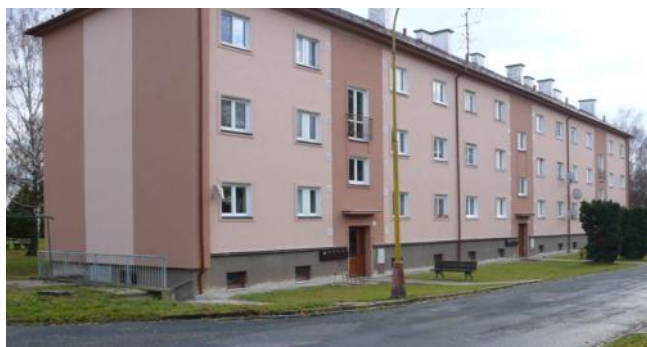
Rekonstrukce elektroinstalace, výměna plastových oken, zateplení štít. stěn na ulici 1. máje 6, 8, 10.
