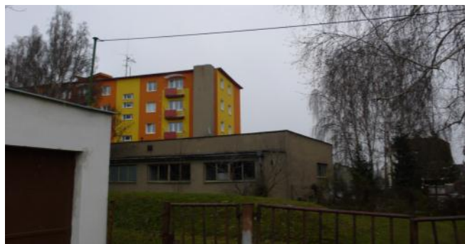
Snížení komínu na kotelně na ulici Adolfa Kašpara.
