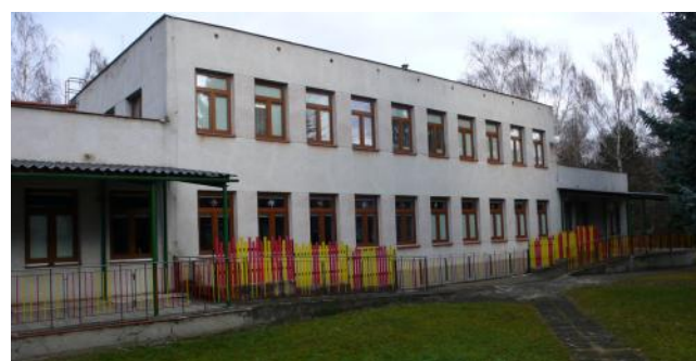
Výměna plastových oken na DDM Magnet na ulici Spartakiádní.
