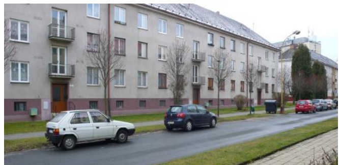
Zateplení půdního prostoru a klempířské práce na Spartakiádní 2, 4, 6. Výměna klempířských prvků a výměna vchodových dveří na Spartakiádní 3, 5, 7. Výměna vchodových dveří na Spartakiádní 10, 12, 14.
