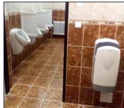
SPŠE s novým sociálním zařízením
