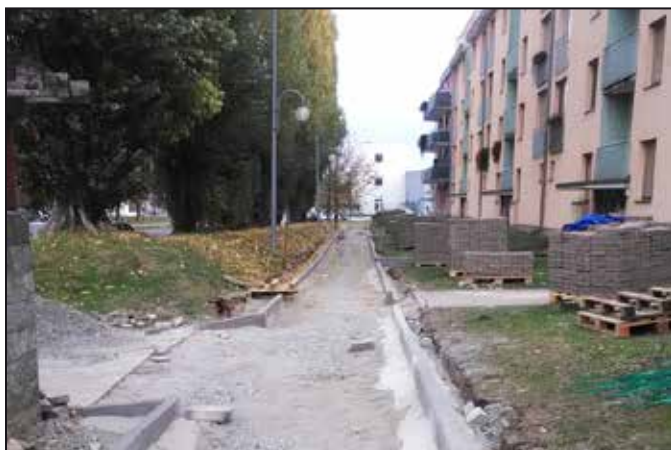
Oprava nekvalitního chodníku Za Penzionem. Foto PRo
