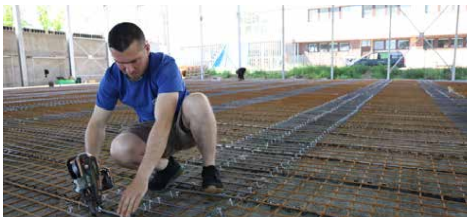
Dělníci připravují podlahu multifunkční sportovní haly na betonáž.
